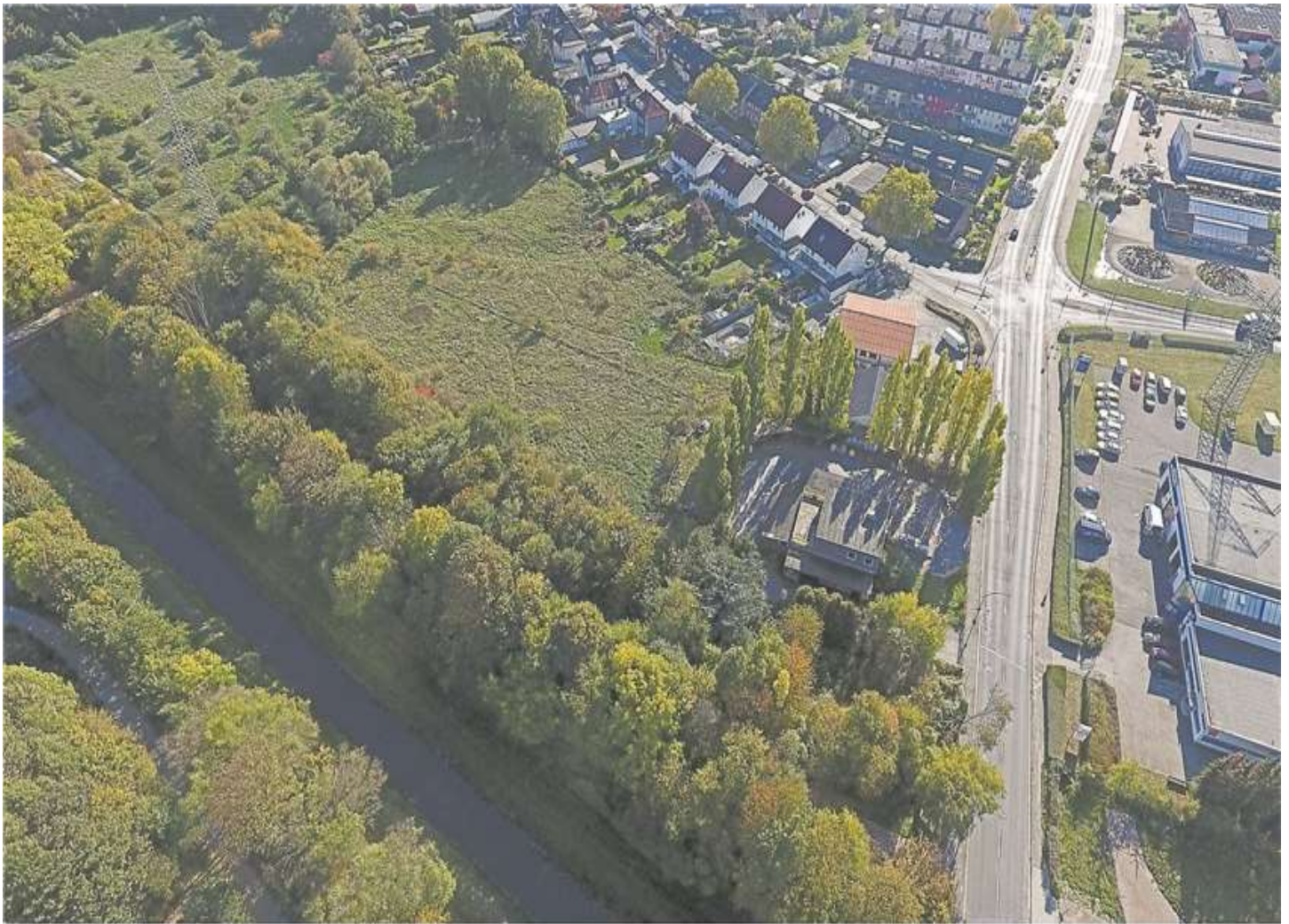
Das Baugebiet „Wohnen an der Emscher“ heißt nun „Am Emscherufer“. Hier sollen rund 70 Wohneinheiten entstehen.
